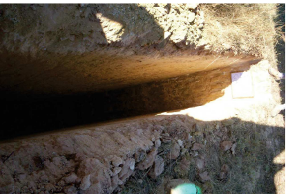
CALIA 6 - DETALLE DE EXCAVACION.
