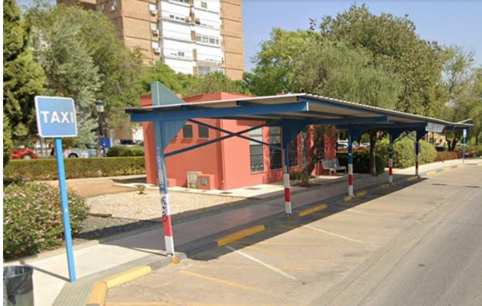
Imagen 3. Marquesina de taxi. Mayor anchura de calzada en ese punto.
