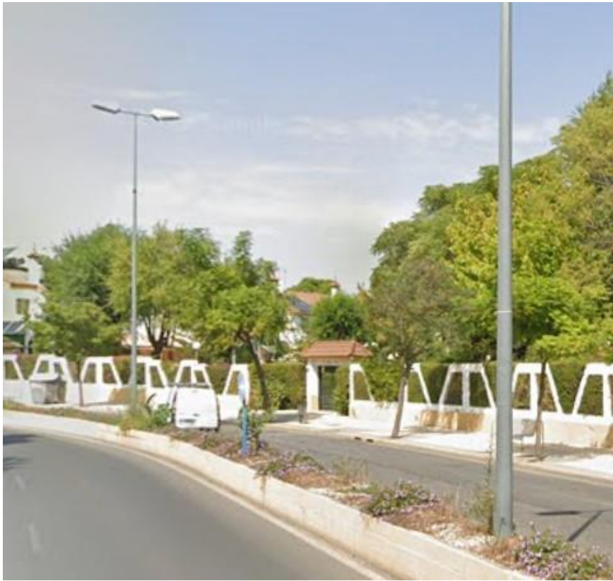
Imagen 15. Alineación de farolas de poste para alumbrado sobre murete de separación.
