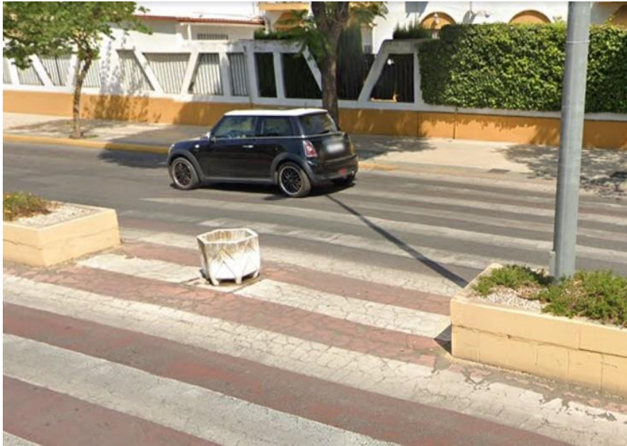
Imagen 11. Paso de peatones en mal estado. Mobiliario urbano de separación entre carriles de sentidos opuestos.
