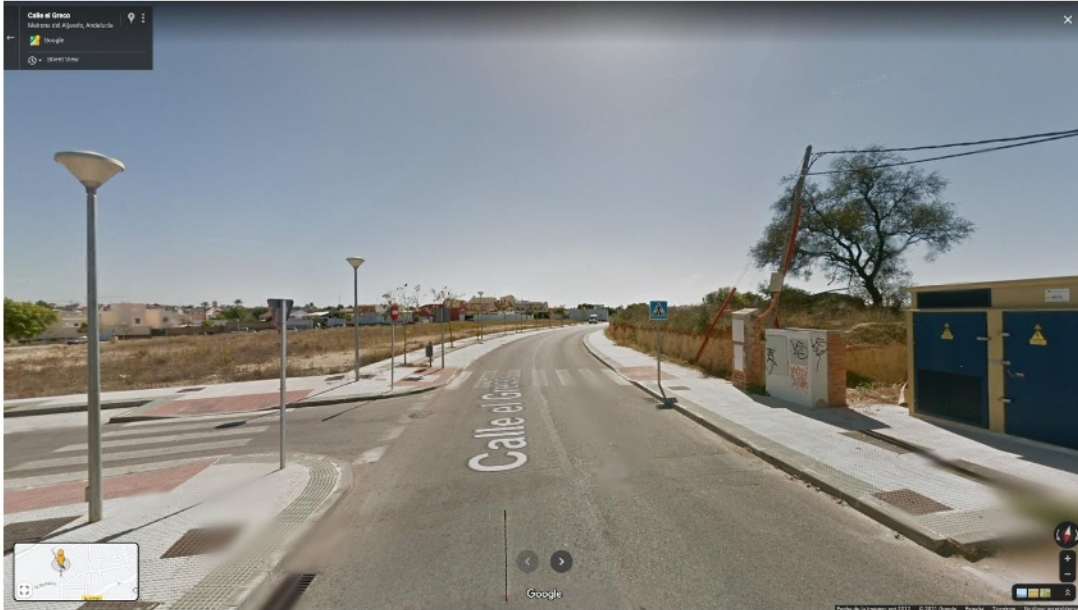
Foto 5. Camino de Peralta (Calle El Greco) con vuelta a Calle Ceuta (Esquina NW). CENTRO DE TRANSFORMACIÓN CT2
