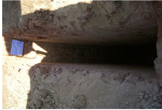
CATA 4 – DETALLE DE EXCAVACIÓN.
