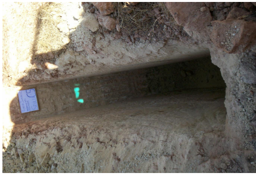
CATA 5 - DETALLE DE EXCAVACIÓN.
