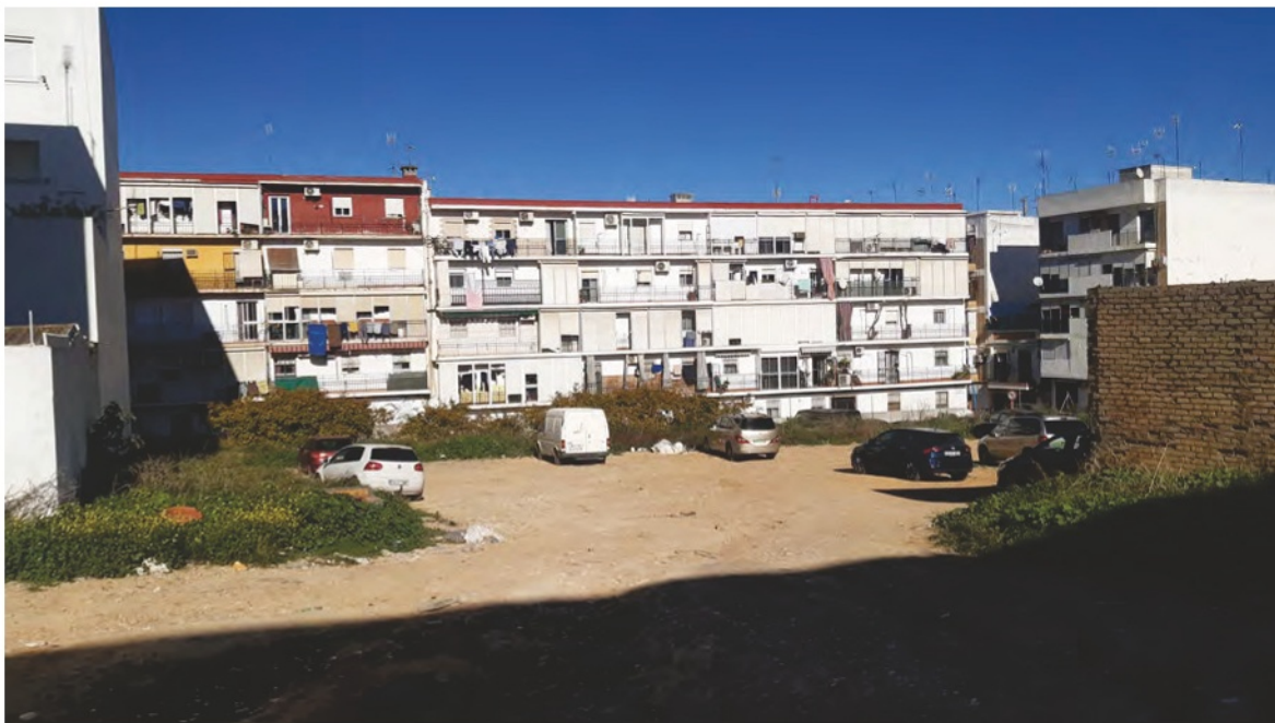
Estado actual del sector
