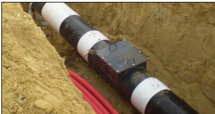
Figura 7. Registro de tubería en zanja
