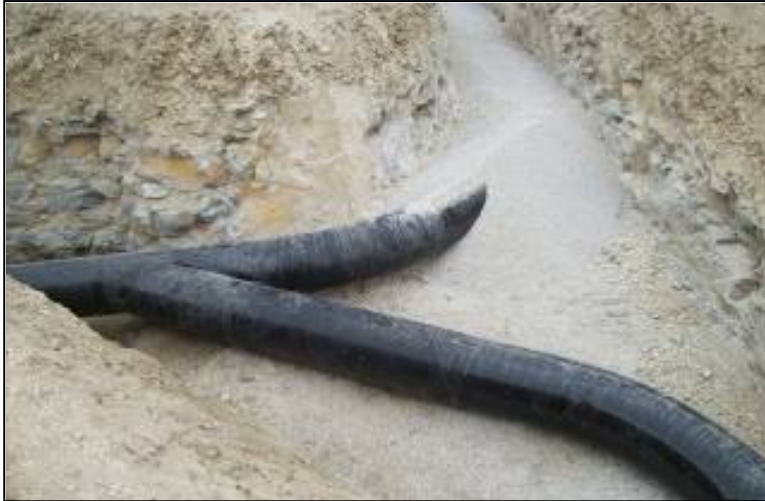
Figura 5.Unión de dos ramales mediante entronque
