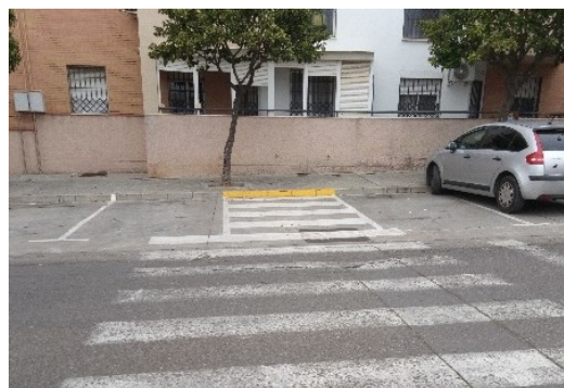
Paso de peatón inaccesible C/San José Obrero
