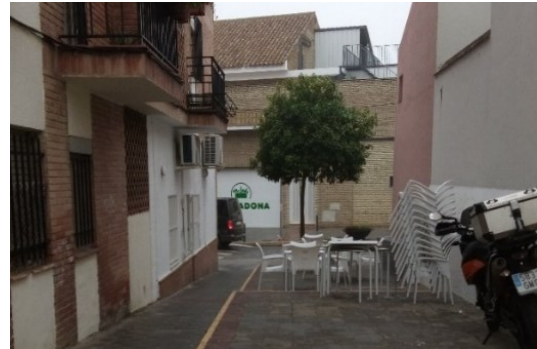
Reducción del ancho de vía transitoria entre C/nueva y Av. de la Libertad.
